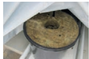
Figuur 6 Afgedekt schoon steenwol in potten.
